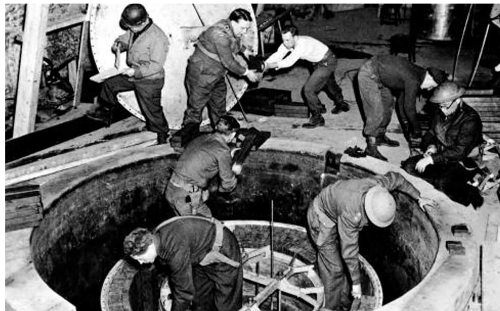
Réacteur atomique allemand dans l'état où le trouvèrent les Américains qui se dépêchèrent de le démonter afin que les Français ne s'en emparent pour le remettre à l'équipe du professeur Frédéric Joliot-Curie (50 km au sud-ouest de Stuttgart, Avril 1945).
